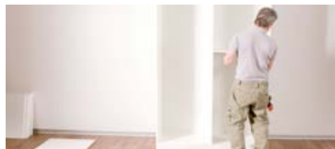
Na de montage de vaste tussenplanken op de gewenste positie bevestigen.
